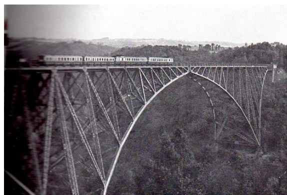
2 Autorails 2800 Lyon Toulouse Viaduc de Viaur (12)
