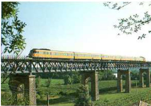
Saint André-de-Cubzac Deux RGP2 X-2700 et le Viaduc
