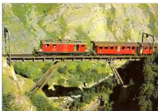
Locomotive pour crémallière HGe 44 37 Pont Steffenbach
