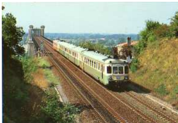
RTG T2000 sur la rampe d'accès au Viaduc
