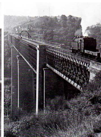
au Viaduc de Fades
